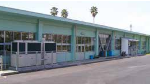
実習工場 Practice factory
