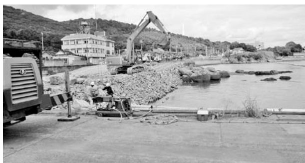
写真3 護岸工事施工現場
