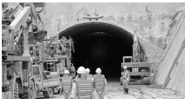
写真1 トンネル施工現場
