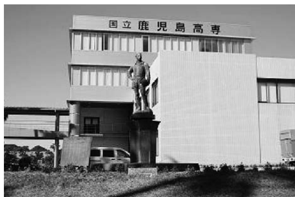
専攻科棟（奥の4階建）と 地域共同テクノセンター（手前）
