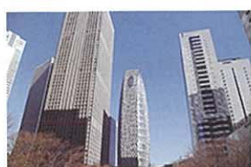
ビル・建物建設
