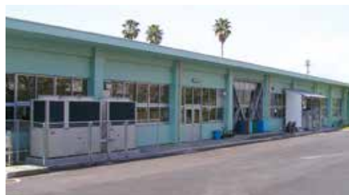
実習工場 Practice factory
