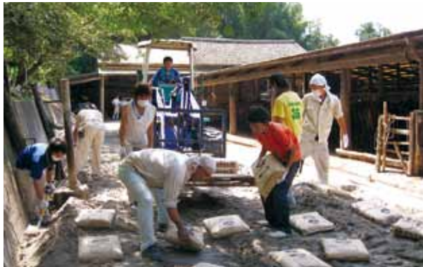
シラスセメントを用いたパドック舗装の試験施工 Trial construction of paddock pavement with Shirsu Cement
