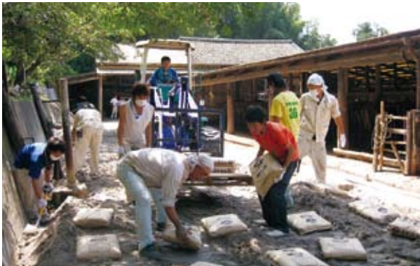
シラスセメントを用いたパドック舗装の試験施工 Trial construction of paddock pavement with Shirusu Cement
