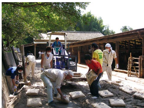
シラスセメントを用いたパドック舗装の試験施工 Trial construction of paddock pavement with Shirsu Cement
