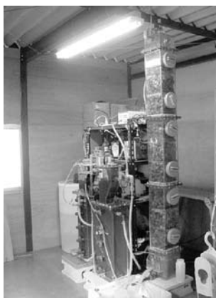
写真 UASB-DHS 処理システム
