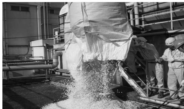
図 5.1 ソフトロンキューブの施工例
