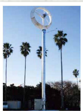
3kWレンズ風車 可倒タワー式 耐風速42m/s 48V独立バッテリー充電タイプ 水素製造装置 燃料電池1kW 併設
