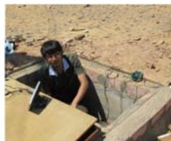
磁力計設置作業（アスワン）
