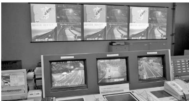
写真2 国道監視管理システム
