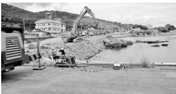
写真3 護岸工事施工現場
