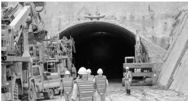
写真1 トンネル施工現場
