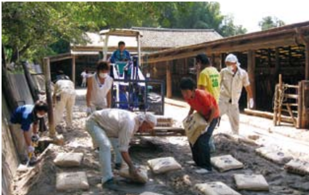
シラスセメントを用いたパドック舗装の試験施工 Trial construction of paddock pavement with Shirasu Cement
