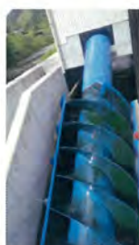
写真 16 小水力発電所見学&螺旋水車発電機
